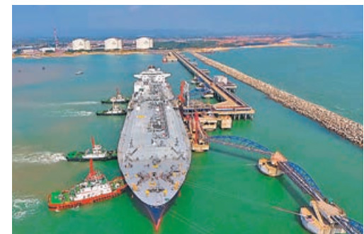
■ 中海油粵東LNG接收站。
