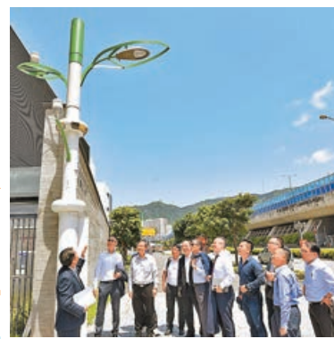
委員視察智慧燈柱的內部結構及智能裝置。
