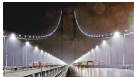
圖為虎門二橋泥洲水道進行橋荷載試驗。中新社
