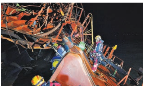
■消防架設繩索系統協助進艙搜救。
